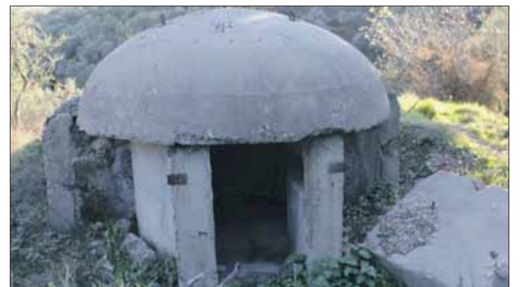
Albaania on kuuluisa bunkereistaan. Niitä valmistettiin teollisesti sarjatyönä vielä sotien jälkeenkin, jotta jokainen albaani saisi oman bunkkerinsa.
