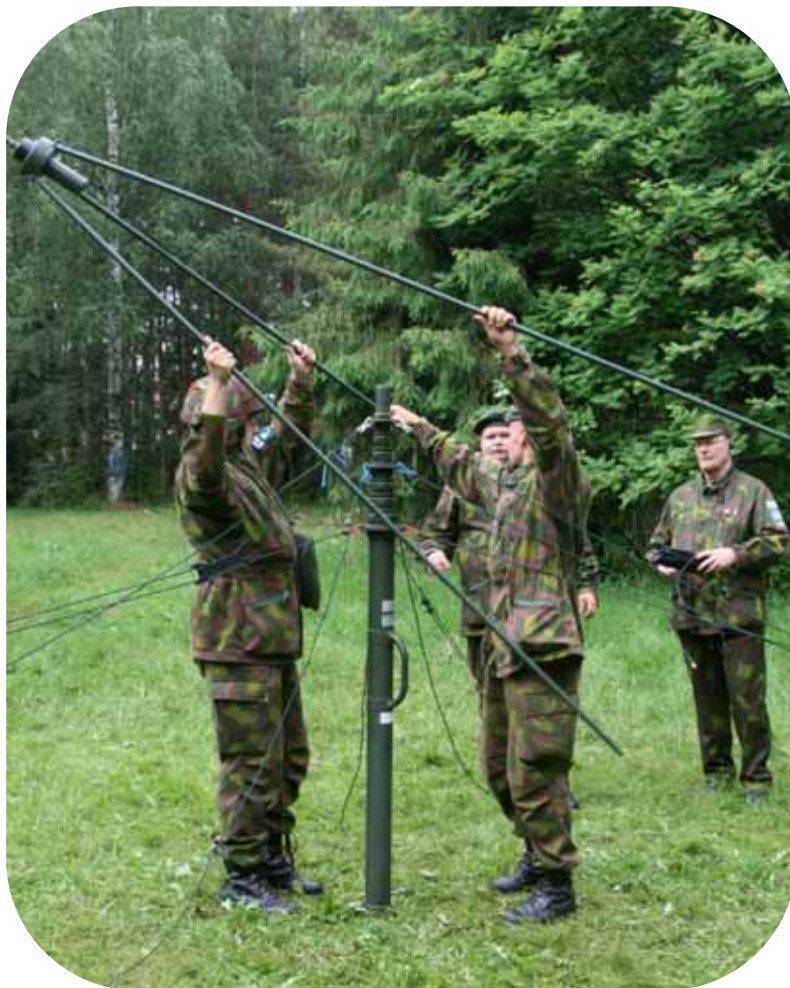
Ex1 mastokin saatiin pystyyn Miikka Ranisen ohjeita noudattaen. "Kiristäkää vaijerit tarpeeksi tiukalle, äläkä koskaan irrota otetta mastosta."
